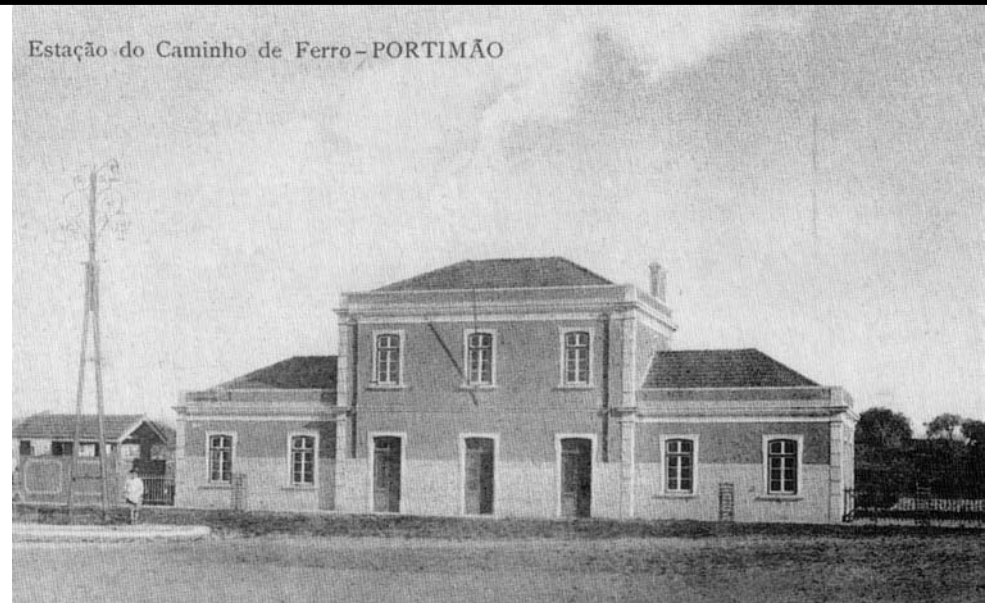
Estação de Portimão, data desconhecida. In "Estações de Caminho de Ferro Através do Bilhete Postal, Ecosoluções, Consultores Associados Lda., Lisboa, 2000.
