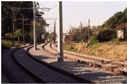
Assentamento da (nova) linha do Metro do Porto para lá de Pedras Rubras (10-04-2005), ainda por estrear, naquele que era o terreno da linha (estreita) da Póvoa.
