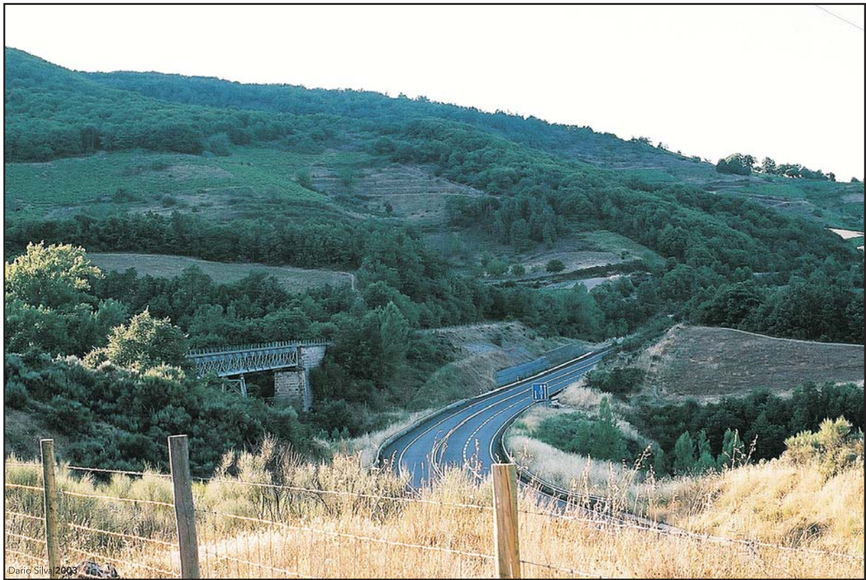
A antiga ponte ferroviária de Rebordões junto ao IP4.
