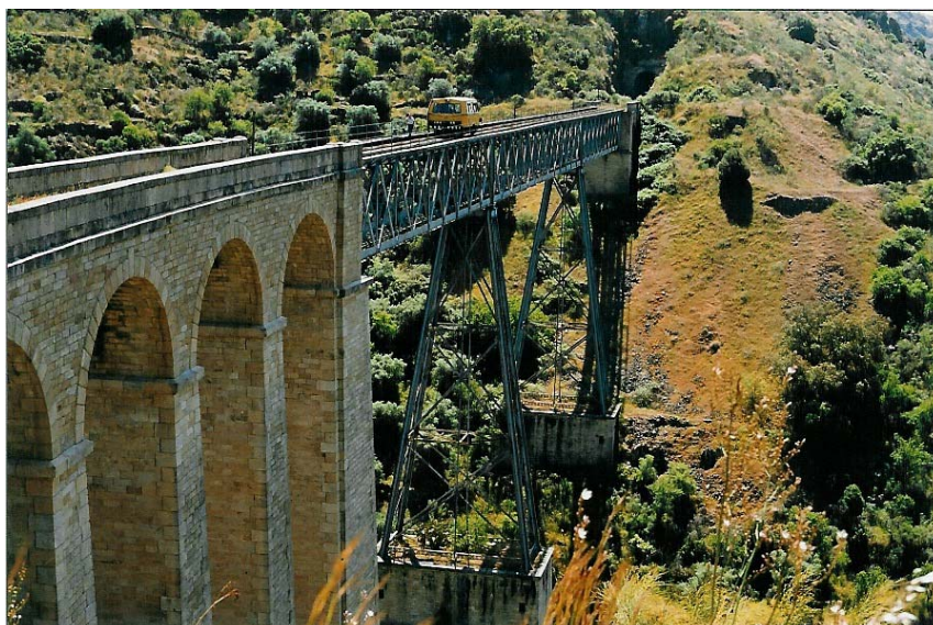
Fotografia 3: Ponte do Arroyo del Lugar (as "troneras" na base de pedra dos pilares metálicos)
