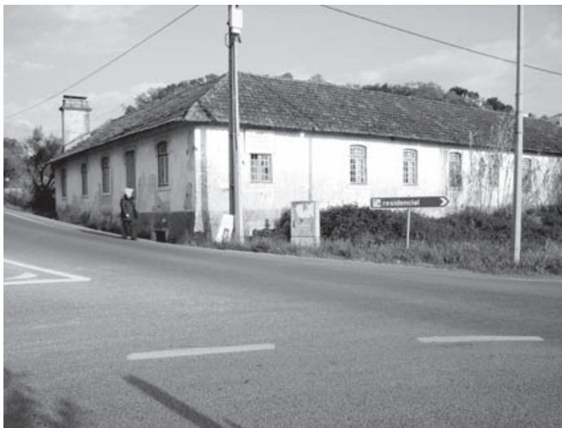
Casa da Freiria na actualidade (exterior)
