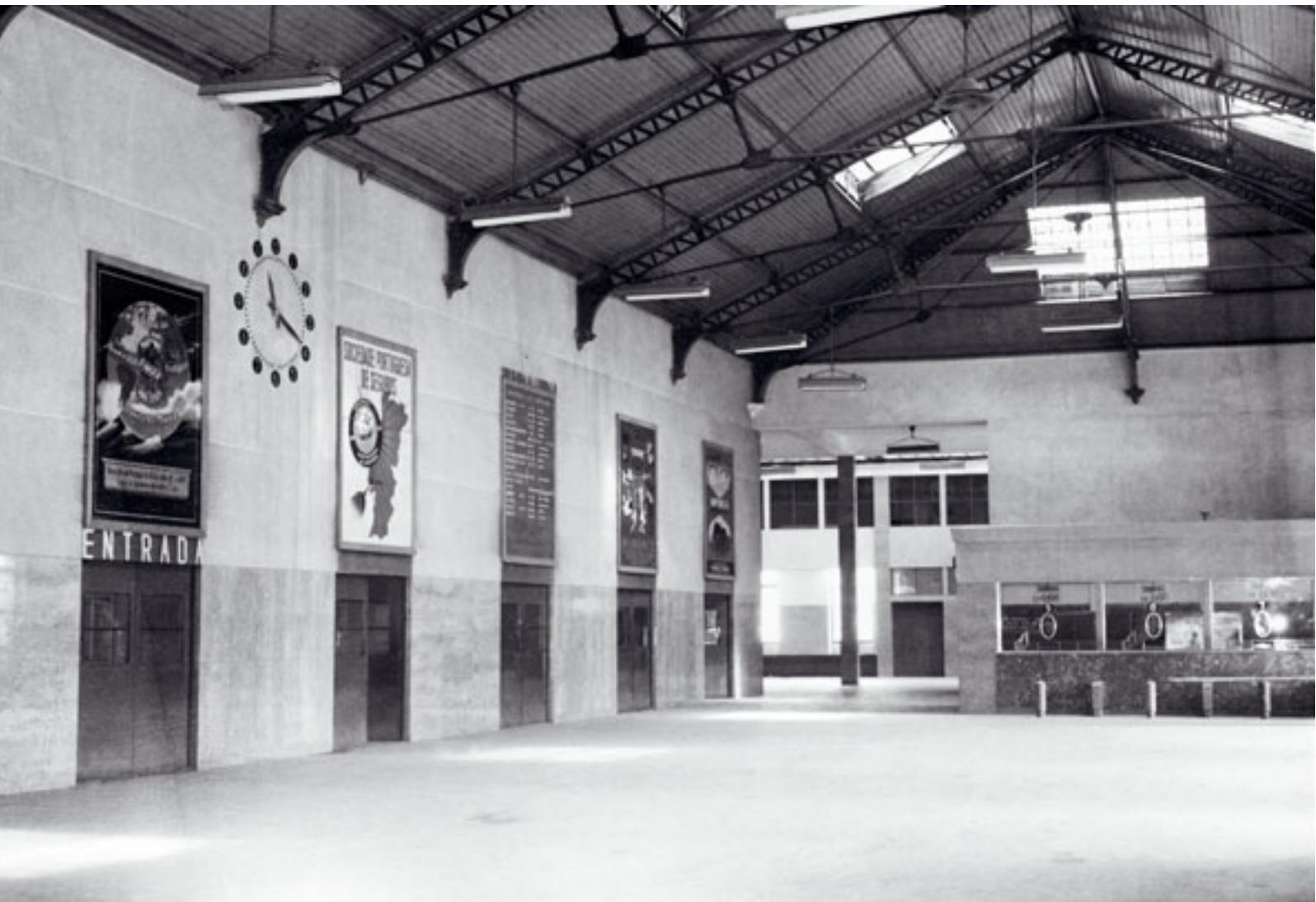
As colunas de ferro negras e esguias foram revestidas com mármore reluzente. E de mármore é também o pavimento que até à pouco era de betonilha. As barracas de madeira desapareceram completamente e as velhas bilheteiras foram substituídas por outras, amplas e arejadas, com cromados e chapas de cristal. O tecto é branco, a luz clara, tudo respirando limpeza e bom gosto.
